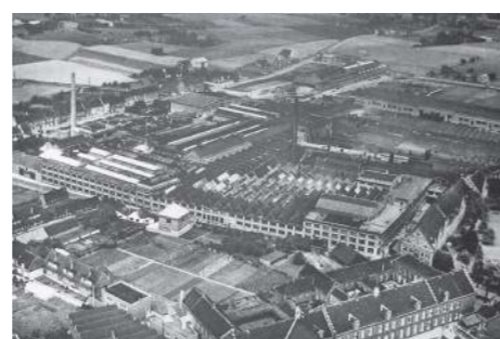
Bekaertsite Zwevegem, begin jaren '70
